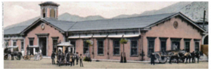
Estación de ferrocarriles de Copiapó, declarada Monumento Nacional en 1981.
