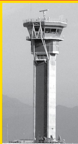
Torre de Control del aeropuerto Comodoro Arturo Merino Benítez
