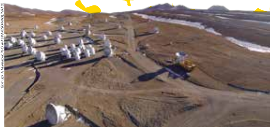
Vista desde lo alto de la llanura de Chajnantor a las 66 antenas de ALMA.
