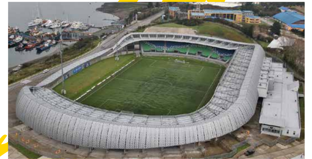
El renovado Estadio Regional de Chiquihue en el sector costero del Canal Tenglo.
