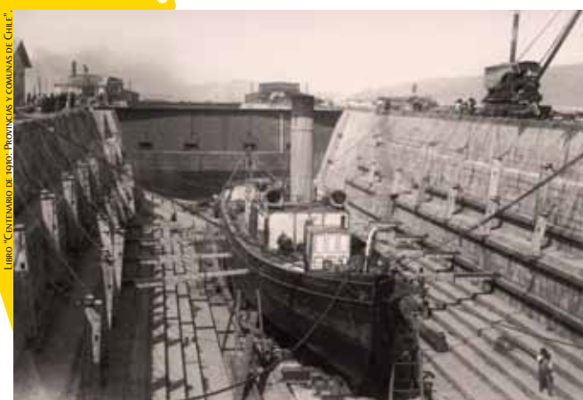
Dique en construcción, hacia 1888.
