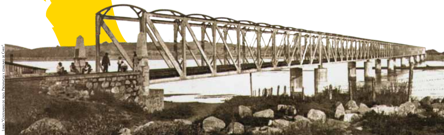
Por su ubicación, San Rosendo fue el principal centro ferroviario del sur, a principios del siglo XX.
