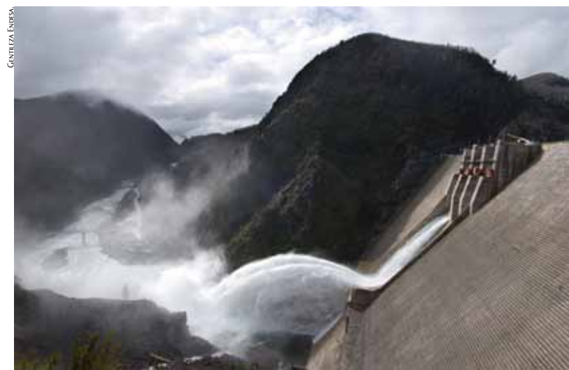
La Central Hidroeléctrica Ralco aporta un 10% de la generación del SIC (Sistema Interconectado central).
