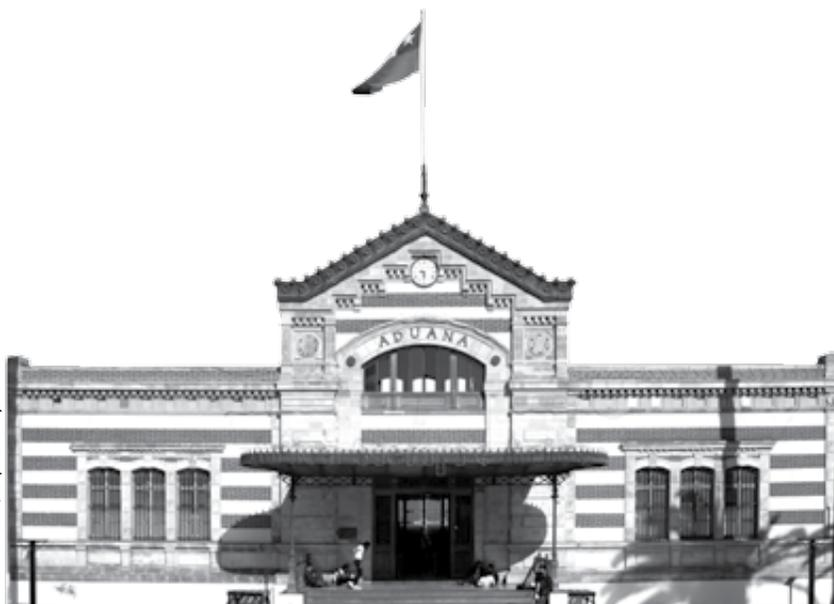
Edificio de 1874, de diseño neoclásico, posee muros de ladrillo, estructura metálica en el techo y en el interior tiene un altillo en el segundo piso con escalera de caracol.
