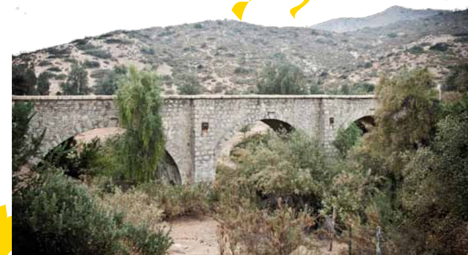
Puente de piedra “La Laja”, Monumento Nacional.
