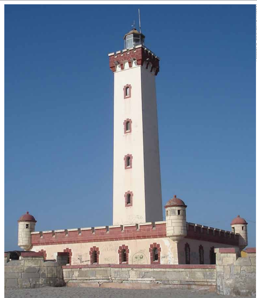
El Faro de La Serena fue construido con un fin decorativo, pero hoy, gracias a la Armada, ilumina a los navegantes.
