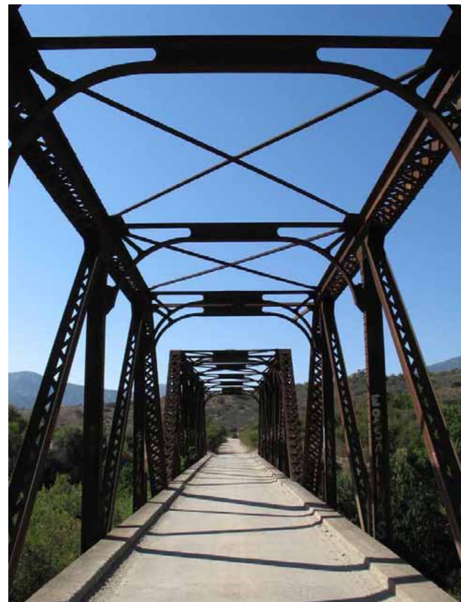
Puente metálico “Tilama”, Monumento Nacional. Se cree que el camino interior que cruza éste y otros puentes, fue construido sobre una antigua ruta incaica.
