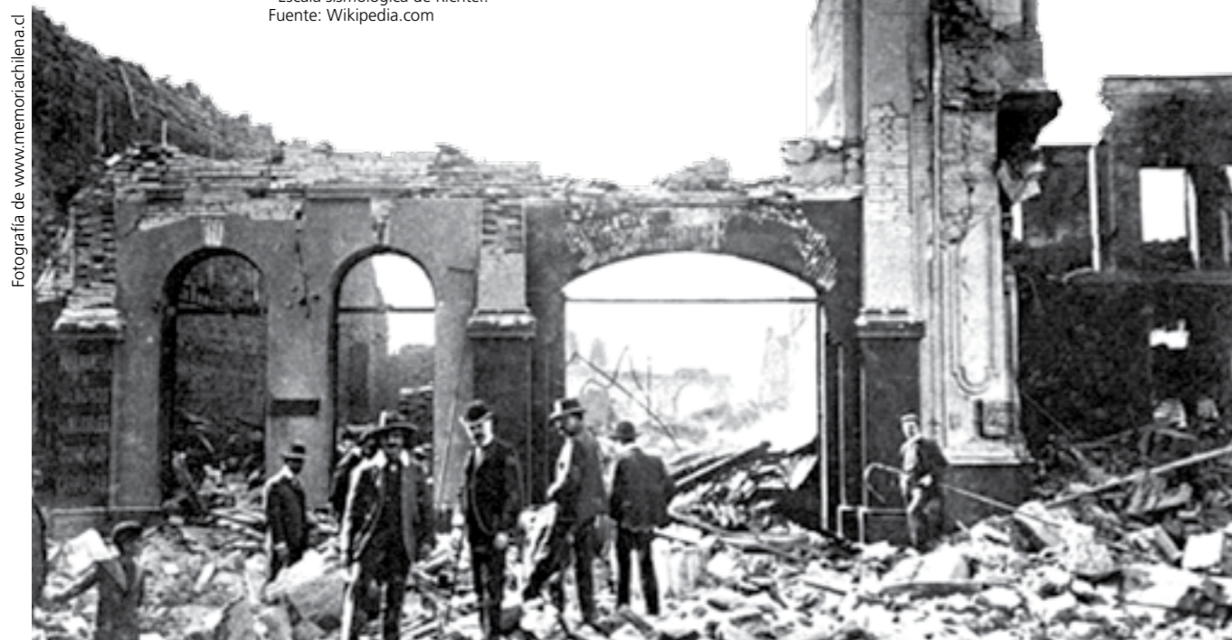
Visita de inspección al Barrio El Almendral de los daños causados por el terremoto de 1906.
