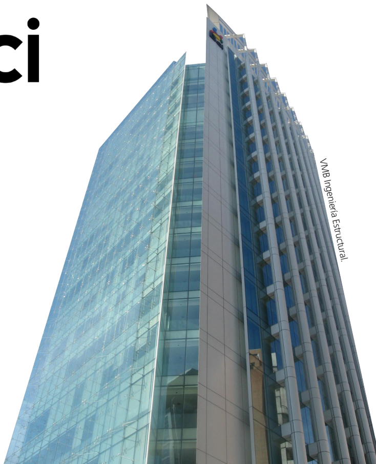
Edificio BCI, El Golf, LAS CONDES.
