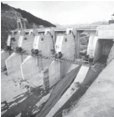
En términos simples, es la energía producida debido a la fuerza ejercida por un caudal de agua que cae sobre las hélices de una turbina, ésta hace girar un generador que va acoplado a ella, produciendo así la electricidad.
