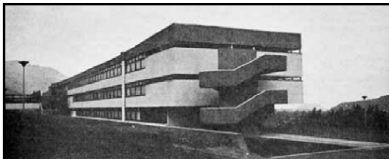
Edificio del CPEIP ubicado en los altos de la comuna de LO BARNECHEA.
